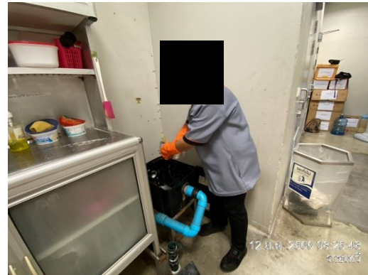
รูปที่ 2-13 แม่บ้านตักไขมันออกจาก Grease Trap
