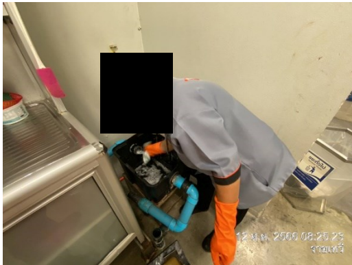
รูปที่ 2-13 แม่บ้านตักไขมันออกจาก Grease Trap
